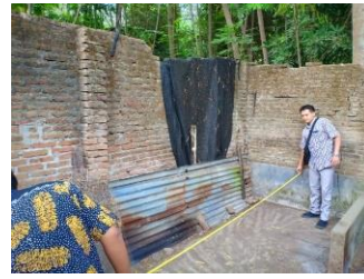
Gambar 4.2 Survey Lokasi Teknologi yang akan di commissioning (Lokasi 2)
