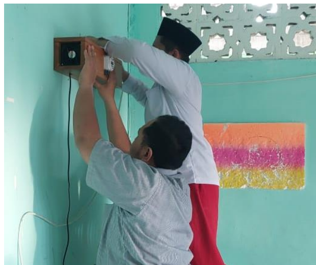
Gambar 2. Proses Pemasangan Alat Netralisator Udara
