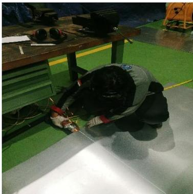
Gambar 6. Proses pemotong seng menggunakan mesin gerinda.
