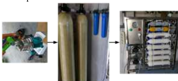
Gambar 3 Pemasangan Mesin RO
