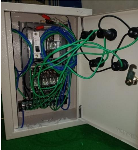
Gambar 7. Rangkaian Kontrol Beban
